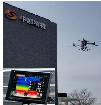
（写真：外壁点検）
